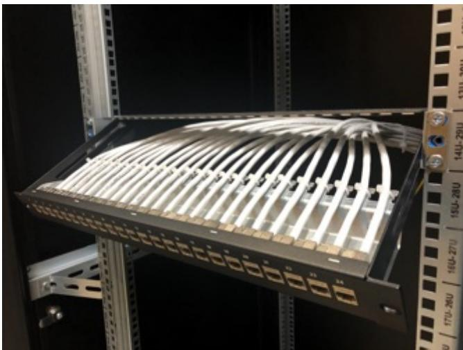
Le support arrière du panneau permet un maintien optimal des câbles
